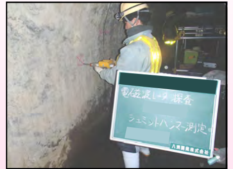
シュミットハンマーによるコンクリート強度測定
