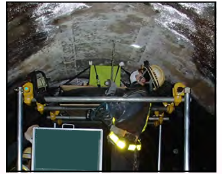
覆工厚、緩み領域測定のための削孔
