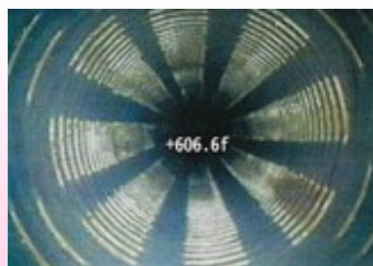
下部カメラ画像(ケーシング内)
