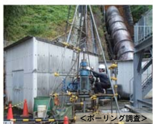
<ボーリング調査>
