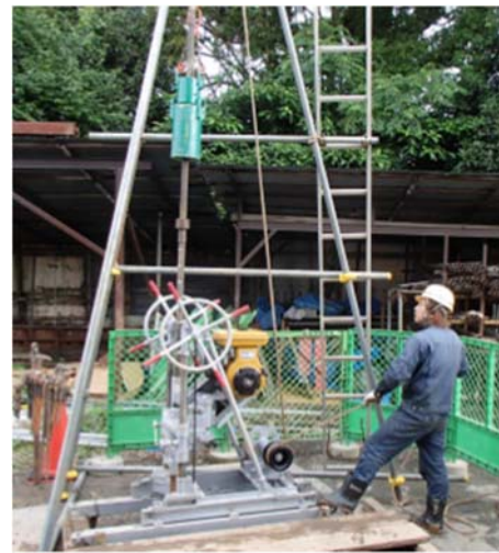
写真-2 標準貫入試験状況
