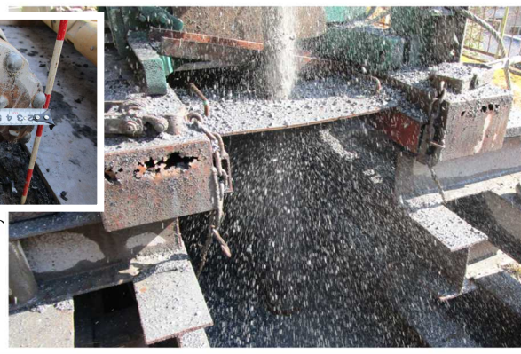
圧縮空気によりスライムと共に地下水を噴き上げる（湧水の概要を把握できる）。
